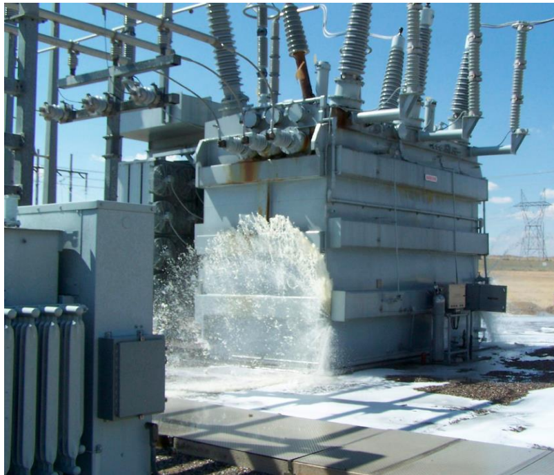
ภาพที่ 35 อุบัติเหตุที่เกิดจากถังหม้อแปลงเสียหาย
