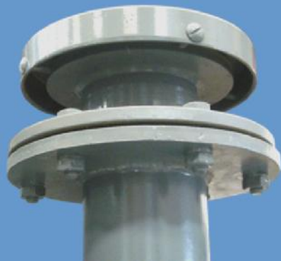
อุปกรณ์ระบายความดันภายในถัง (เฉพาะหม้อแปลงที่มีถังน้ำมันสำรองเท่านั้น)
